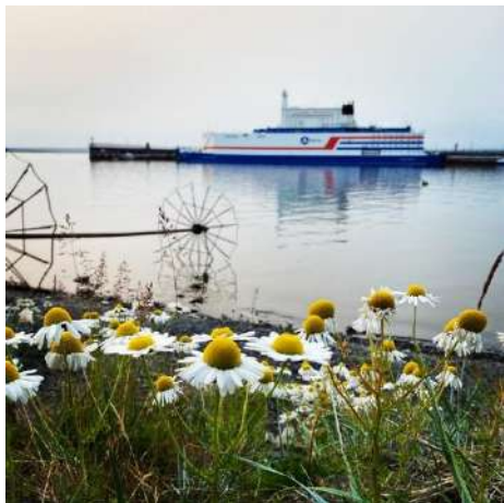
Плавучая атомная теплоэлектростанция
